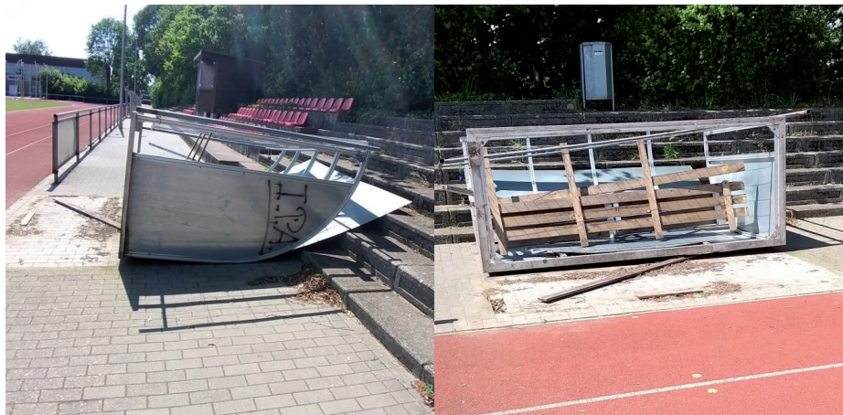
Nach einem Sturm ist eine der Trainerbänke komplett zerstört
